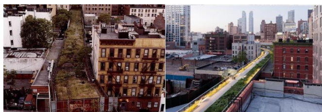
Antes e Depois da Revitalização.
