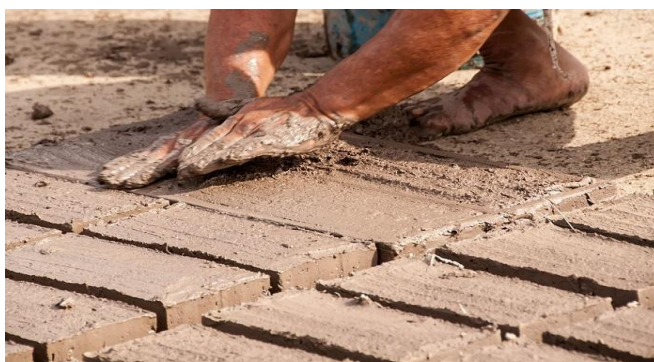
Figura 1 - Tijolos adobe sendo moldados e expostos ao sol para secagem natural Fonte: Blog Qualidade Online (2020)
