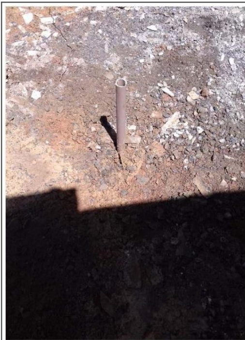
INA (Indicador de N instalado no SP03)
