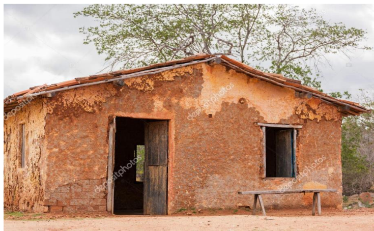
Figura 3 - Casa no interior de Minas Gerais, com adobe exposto Fonte: Barroso (2016)
