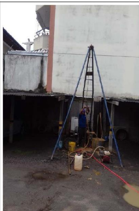
Equipamento de Sondagem em Operação
