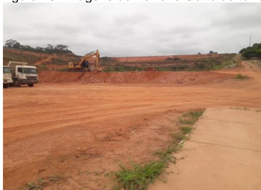
Figura 16: Imagens do Terreno Corte de terra
