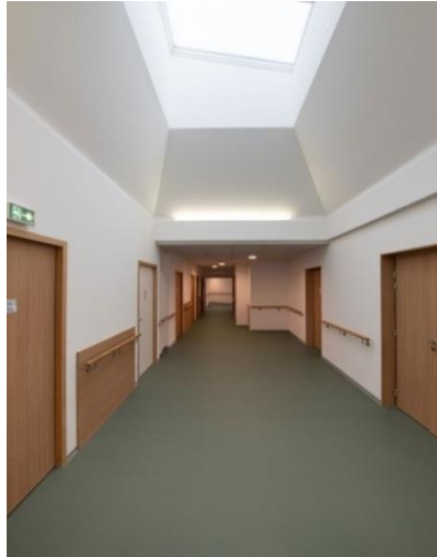
FIGURA 22: Iluminação por meio de claraboia no interior da clínica.
