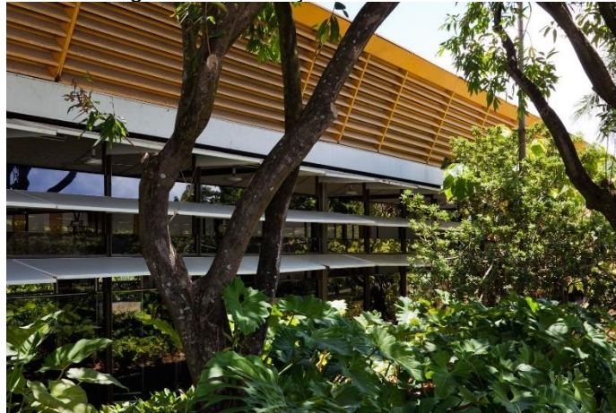
Figura 17 – Vedação do shed. Parte 2.
