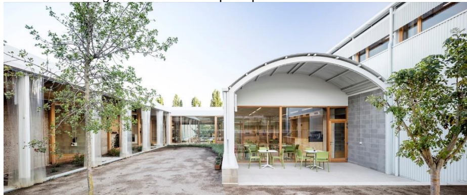
Figura 13 – Fachada principal do Centro médico.
