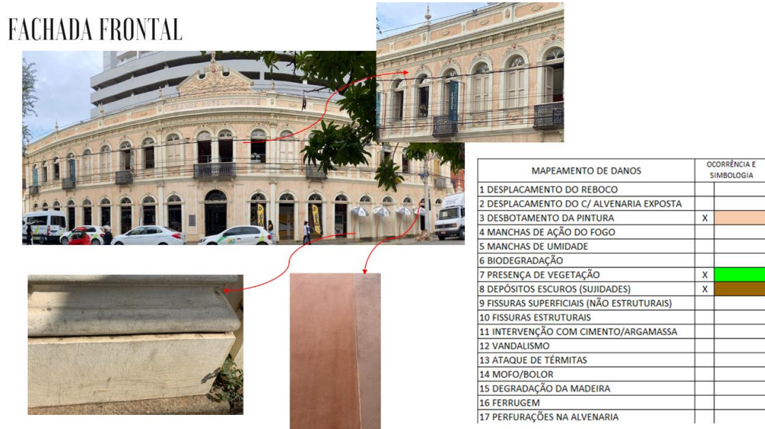
FIGURA 36 – Mapeamento de danos Fachada Frontal
