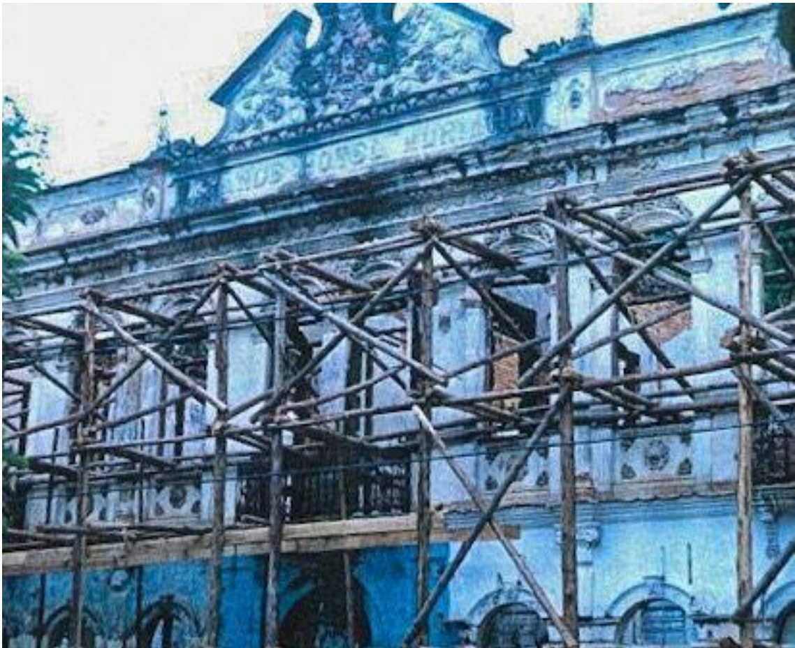
FIGURA 09 – Escoramento das fachadas danificadas pelo fogo, 1998
