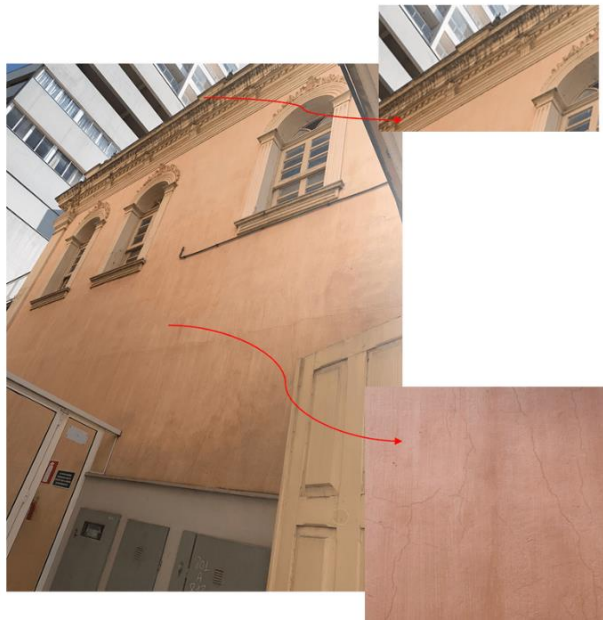
FIGURA 41 – Ilustração de danos na Fachada Lateral Esquerda
