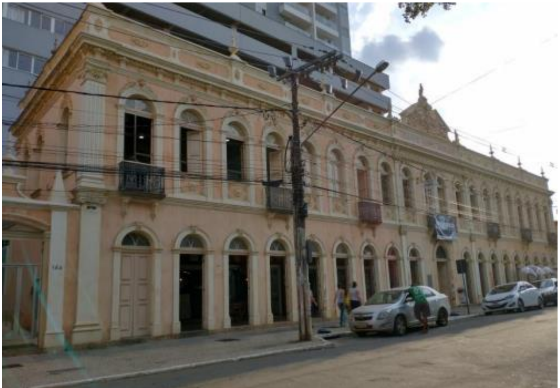
FIGURA 10 – Vista Parcial da fachada, 2021
