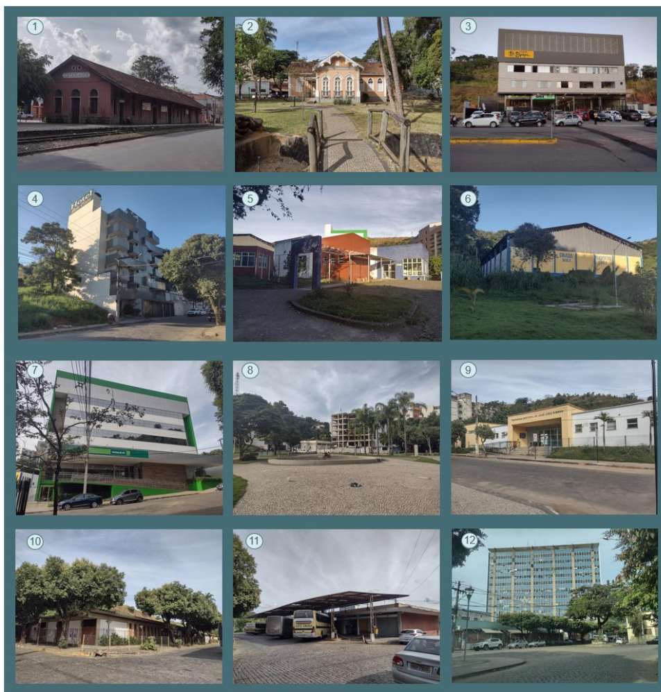
Figura 45- Pontos nodais do entorno da área de intervenção, fotografias tiradas em 2023
