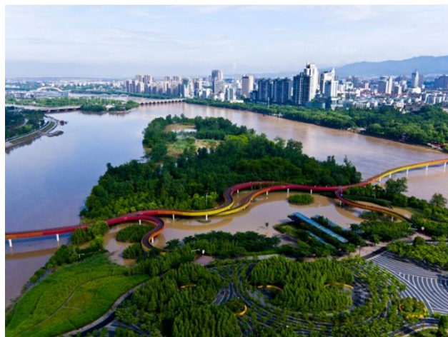
Figura 9- Parque Alagável Jinhua Yanweizhou, China
