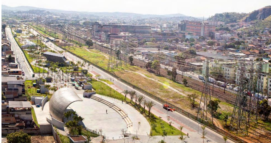
Figura 16- Vista superior de um trecho do Parque Madureira
