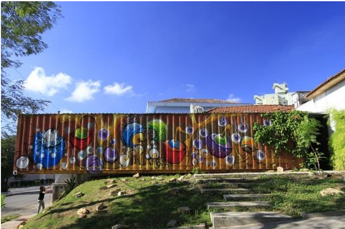
Figura 9 – Fachada Escritório Ateliêr H 2 O
