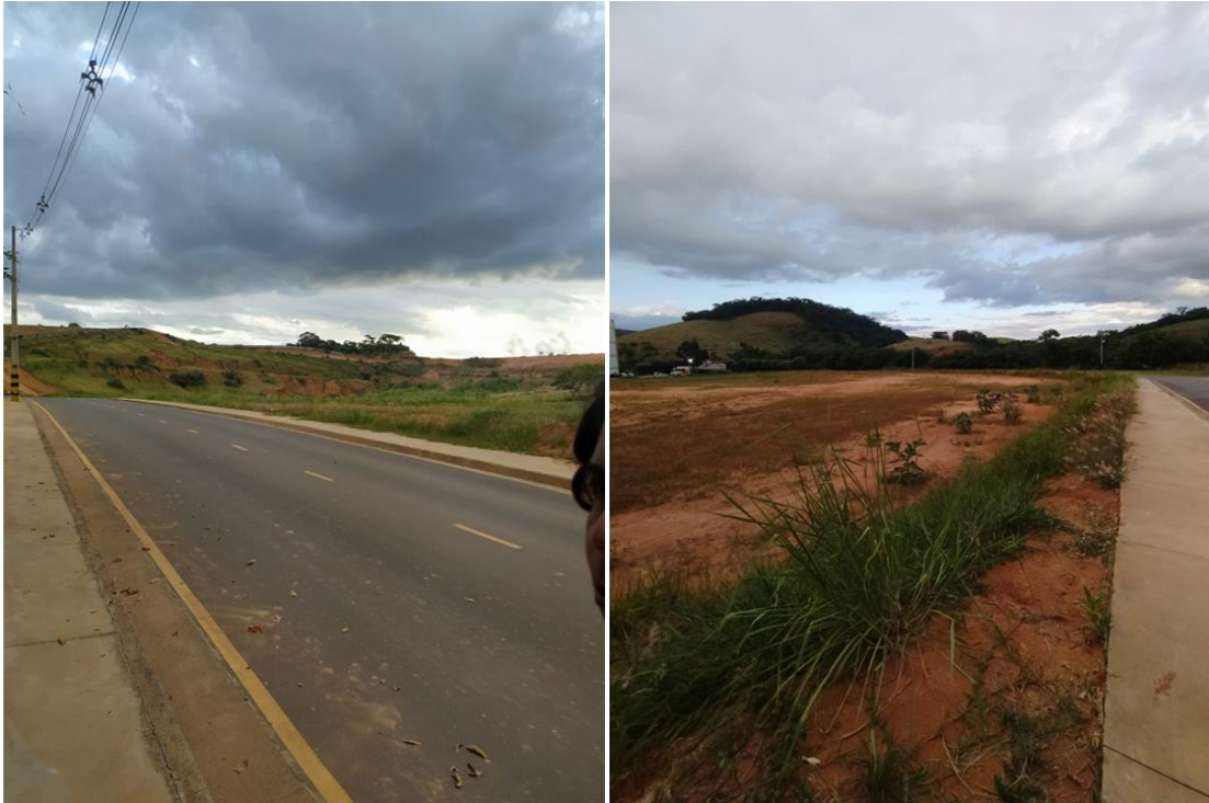
Imagem 13 – Vistas da via frontal ao terreno escolhido
