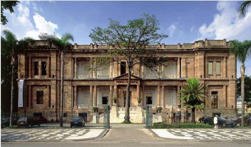
FIGURA 17: Fachada da Pinacoteca
