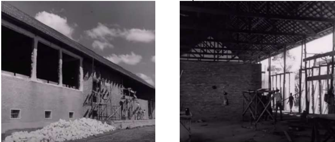
FIGURA 12 E 13: Construção da APAC
