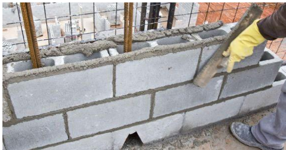
Figura 4: Armadura de aço
