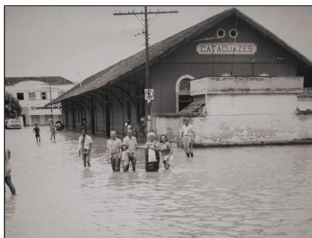
FIGURA 38: Registro histórico sem data, enchente atinge a antiga estação ferroviária.
