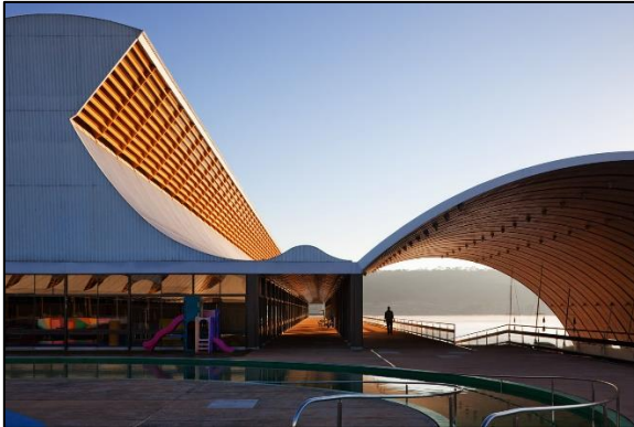
FIGURA 14: Cobertura em Shed.
